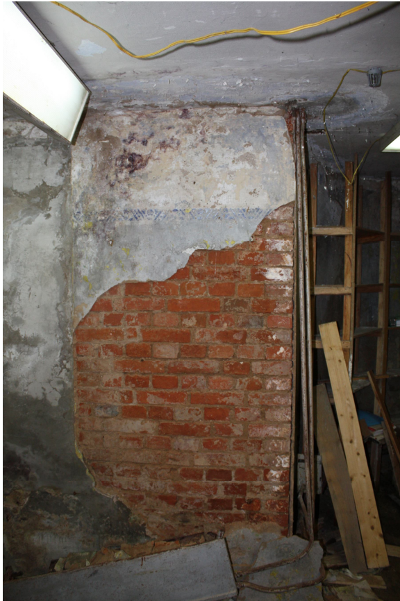
Foto Nr. 54. Apmetuma kārtas noslāņošanās pagrabstāvā telpā Nr. 2
