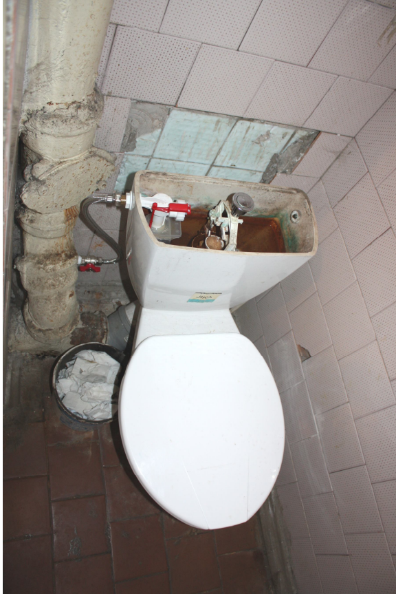
Foto Nr. 73. Kopumā ēkā ir 1 sanmezglis. Klozetpoda skalojamai kastei trūkst nosegvāka. Noskalošanas mehānisms ir bojāts, noskalošana notiek, pieskaroties pašam noskalošanas mehānismam
