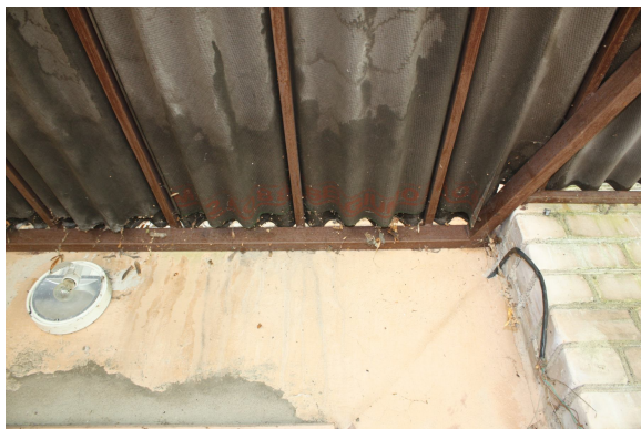
Foto Nr. 37. Jumtiņa segums ir bojājies (izlocies, lokšņu savienojumi ir deformējušies). Lokšņu pieslēgums pie sienas nav hermētisks
