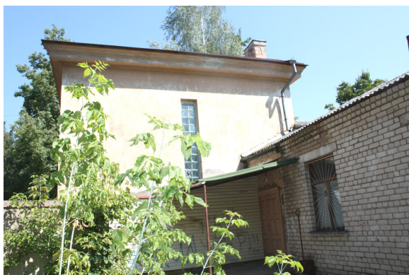
Foto Nr. 2. Ēkas kopskats no Ziemeļrietumu puses. Vecā un jaunā korpusa sajūguma vieta
