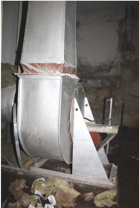
Foto Nr. 99. Pieplūdes ventilācijas sistēmas ventilators, kas, pēc darbinieku liecībām, nav tikusi palaista kopš jaunā korpusa izbūves
