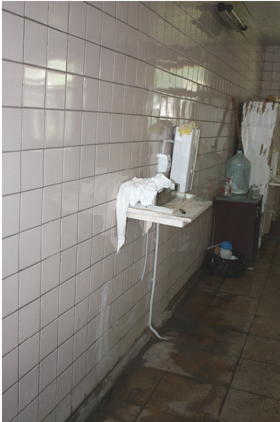
Foto Nr. 40. Telpa Nr. 7. Grīdas segums nav līdzens, nepieļaujamo spraugu no epidemioloģiskajiem apsvērumiem esamība nav noliedzama
