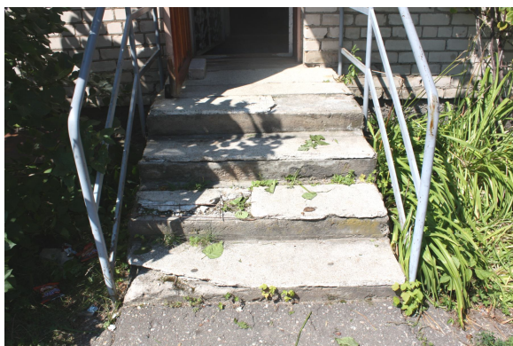
Foto Nr. 35. Lieveņis atrodas neapmierinošā tehniskajā stāvoklī; pakāpienu virsmā ir nelīdzena, to stiegrojums ir atsedzies, kas ietekmē drošu ēkas ekspluatāciju
