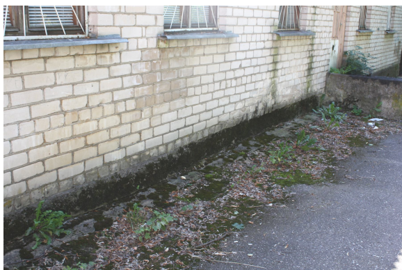
Foto Nr. 19. Mazas jumta pārkares dēļ (sk. Foto Nr. 3), lietus un kušanas ūdeņi netiek novadīti prom no ēkas pietiekami drošā attālumā. Kaut arī vienstāvu ēkām ar slīpņu jumtiem organizētās lietusūdens savākšanas un novadsistēmas nav obligātas, to ierīkošana samazinātu negatīvu nokrišņu ūdens ietekmi uz pamatiem
