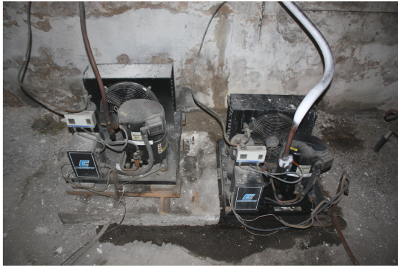
Foto Nr. 98. Kompresori pagrabstāvā; to apvalki nav aizsargāti pret putekļu iekļūšanu tajos
