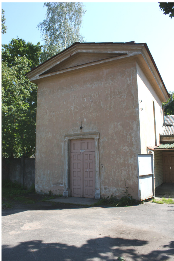
Foto Nr. 1. Ēkas kopskats no Ziemeļrietumu puses. Vecais korpuss
