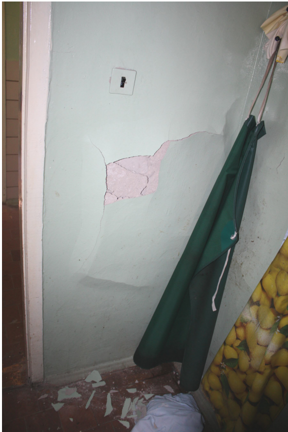
Foto Nr. 61. Apmetuma kārtas noslāņošanās telpā Nr. 13
