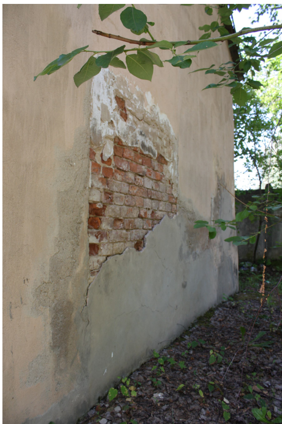
Foto Nr. 10. Praktiski visa ārējā apmetuma virsma cokoldaļas līmenī ir sairusi. Atsevišķās vietās ķieģeļu virsmai ir konstatēti bojājumi – ķieģeļu ārējās virsmas sadrupšana
