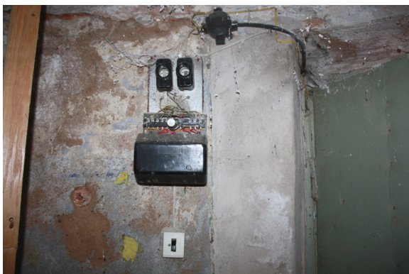
Foto Nr. 89. Elektrosadale ar atklātām strāvadošām daļām. Visi kaili vadu savienojumi ir jānosedz ar aizsargvākiem
