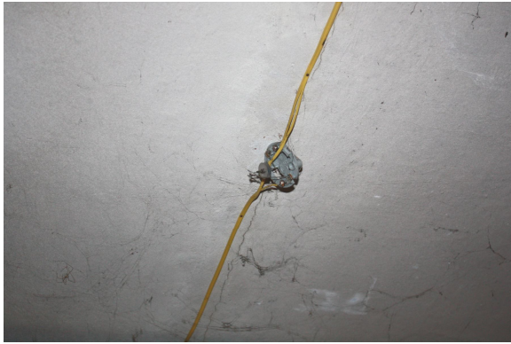
Foto Nr. 95. Bojātais Automātiskās ugunsgrēka atklāšanas un trauksmes signalizācijas sistēmas detektors
