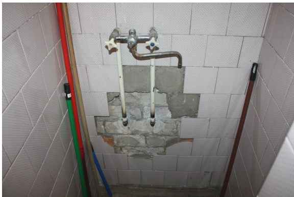
Foto Nr. 58. Flīzējuma kārtas noslāņošanās telpā Nr. 22
