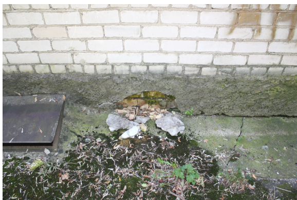
Foto Nr. 18. Ēkas cokoldaļas apmetums ir noslāņojies, atsevišķās vietās apmale ir nosēdusies, ir izveidojušies pretkritumi; sājās vietās pamatu bojājumi ir intensīvāki. Nepieciešama gan pamatu vertikālās un horizontālās hidroizolācijas ierīkošana, gan apmales renovācija
