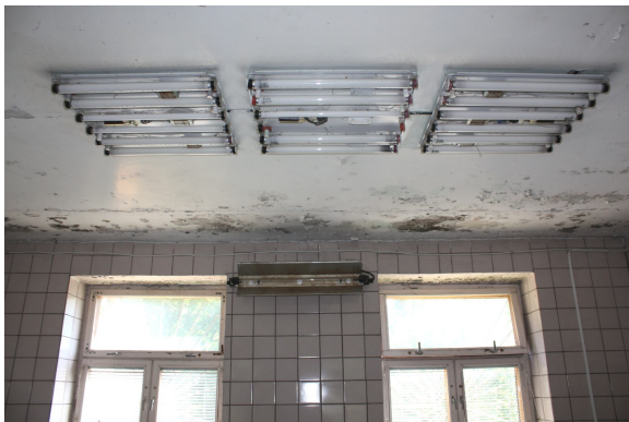
Foto Nr. 91. Gaismekļiem ar luminiscences lampām ir nodrošināma aizsargaizsardzība – plafoni. Gaismekļu IP (International Protection) neatbilst minimāli nepieciešamajai šāda režīma telpai
