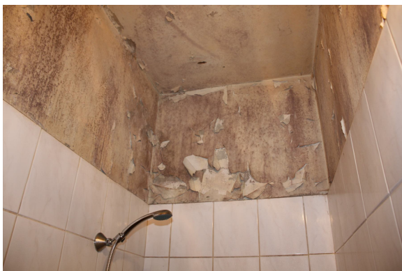
Foto Nr. 59. Krāsojuma kārtas noslāņošanās telpā Nr. 9
