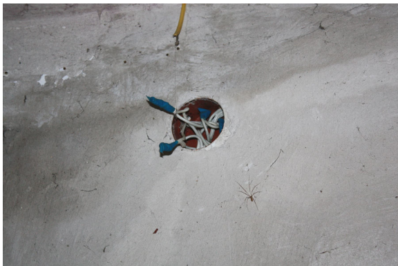
Foto Nr. 88. Alumīnija vadu savienojums ir nedrošs. Tieša vadu saskrūvēšana ir paaugstinātie pretestības posmi elektriskajā ķēdē, kas nav pieļaujams
