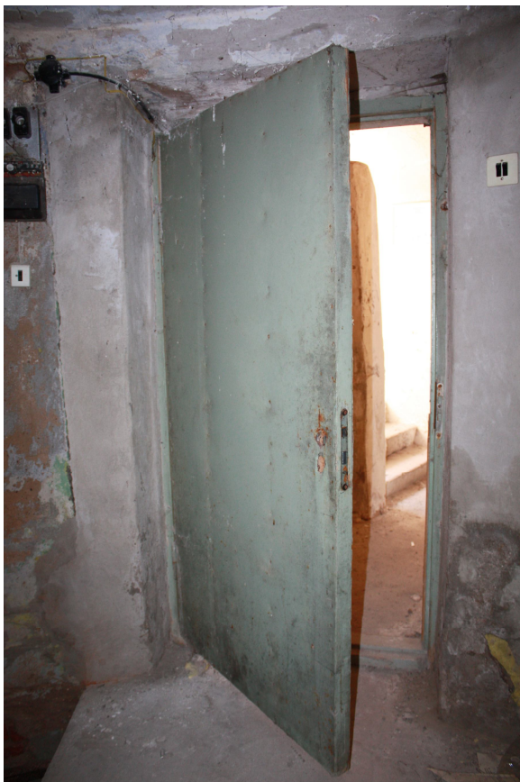
Foto Nr. 44. Pagraba durvis. Durvju vērtnes krāsojums ir nodilis, furnitūra ir bojāta
