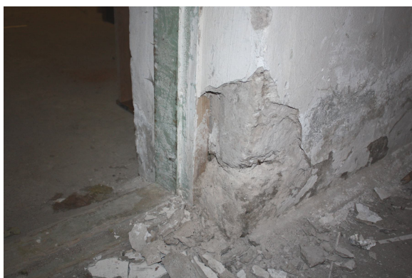
Foto Nr. 27. Durvju aila starp telpu Nr. 4 un 9. Iekšsienas ietekmē gruntsūdens mitrums
