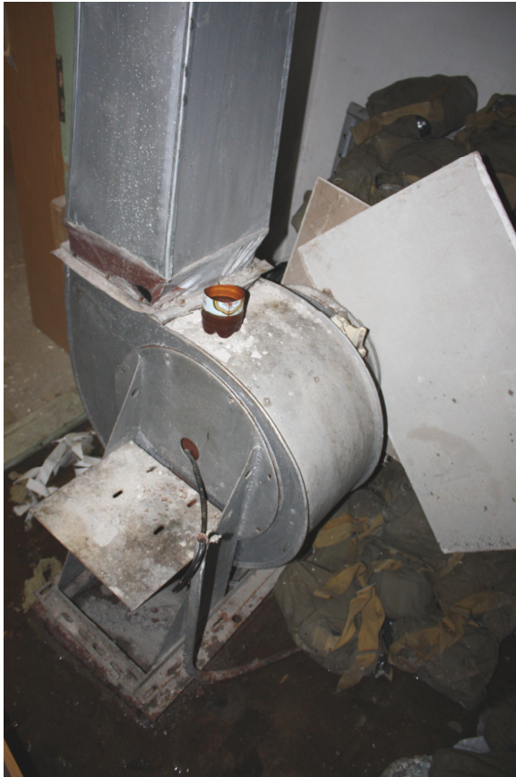
Foto Nr. 100. Pieplūdes ventilācijas sistēmas ventilators, kas, pēc darbinieku liecībām, nav tikusi palaista kopš jaunā korpusa izbūves
