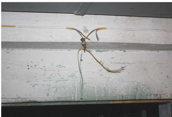
Foto Nr. 97. Mehāniski bojājumi (pārrāvumi) automātiskās ugunsgrēka atklāšanas un trauksmes signalizācijas sistēmas tīklos
