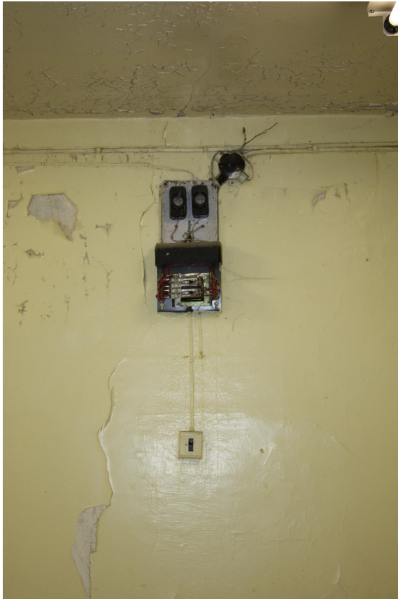
Foto Nr. 90. Elektrosadale ar atklātām strāvadošām daļām. Visi kaili vadu savienojumi ir jānosedz ar aizsargvākiem
