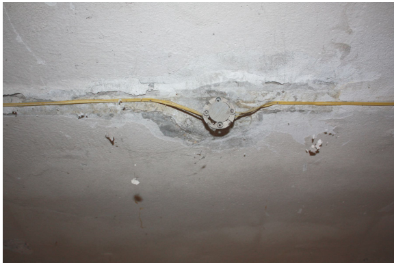
Foto Nr. 96. Bojātais Automātiskās ugunsgrēka atklāšanas un trauksmes signalizācijas sistēmas detektors
