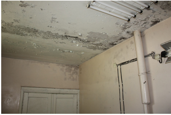
Foto Nr. 63. Pelējums un krāsojuma kārtas noslāņošanās telpā Nr. 5
