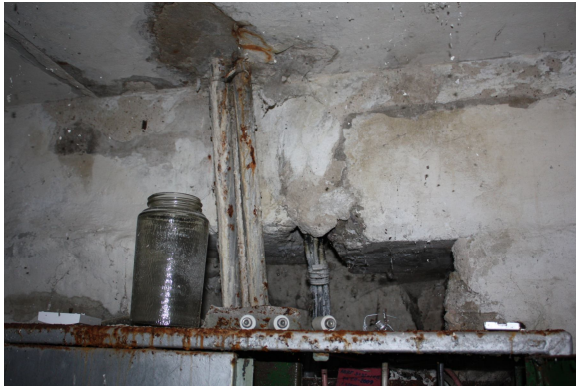
Foto Nr. 52. Elektriskie kabeļi, kas šķērso nesošās konstrukcijas ir ieguldāmi gofrētās aizsargcaurulēs vai čaulās, lai novērstu to mehānisko bojāšanos un iespējamo īssavienojumu
