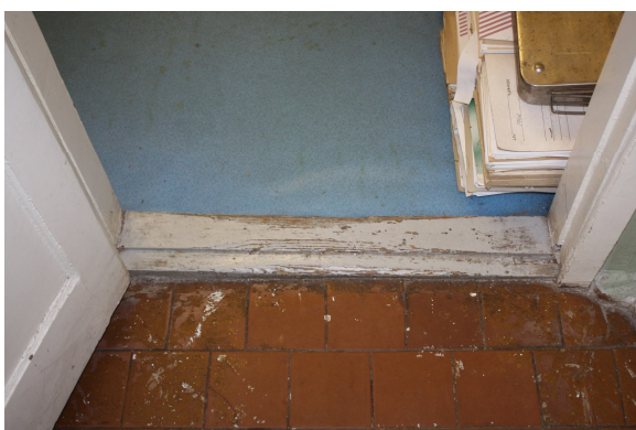
Foto Nr. 45. Iekšējo durvju funkcionāli estētisks stāvoklis ir neapmierinošs. Durvju vērtnes krāsojums ir nodilis, furnitūra ir bojāta vai neatbilst mūsdienu komfortabluma prasībām (personiskās higiēnas telpu durvīm nav atslēdziņu (aizbīdnīšu))
