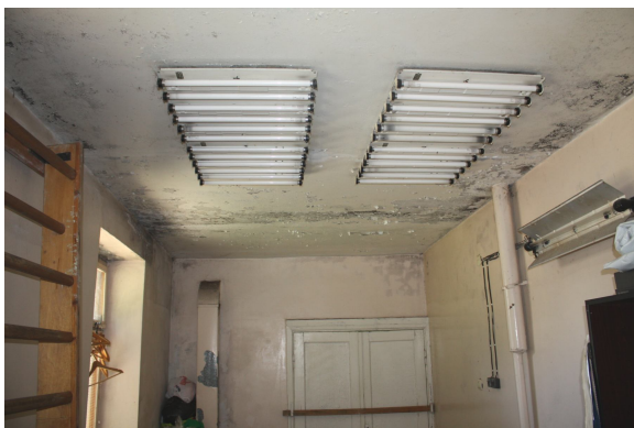
Foto Nr. 92. Gaismekļiem ar luminiscences lampām ir nodrošināma aizsargaizsardzība – plafoni
