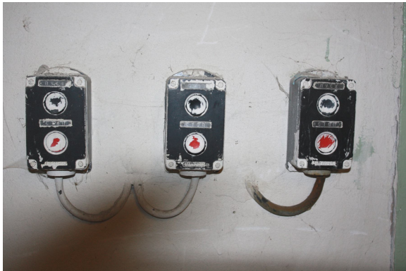
Foto Nr. 84. Ventilācijas sistēmas palaišana ir iespējama tikai no pagrabstāva. Tās automātiskā izslēgšana nav nodrošināta
