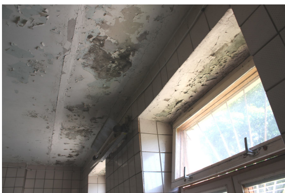
Foto Nr. 62. Pelējums un krāsojuma kārtas noslāņošanās telpā Nr. 7
