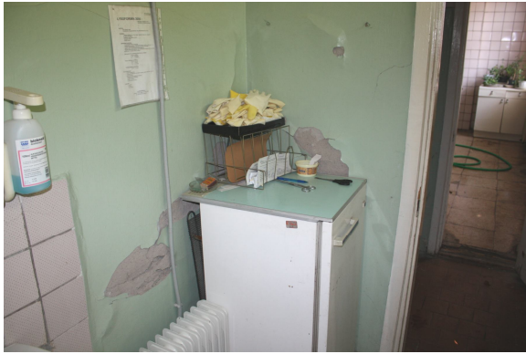
Foto Nr. 60. Apmetuma un krāsojuma kārtas noslāņošanās telpā Nr. 14
