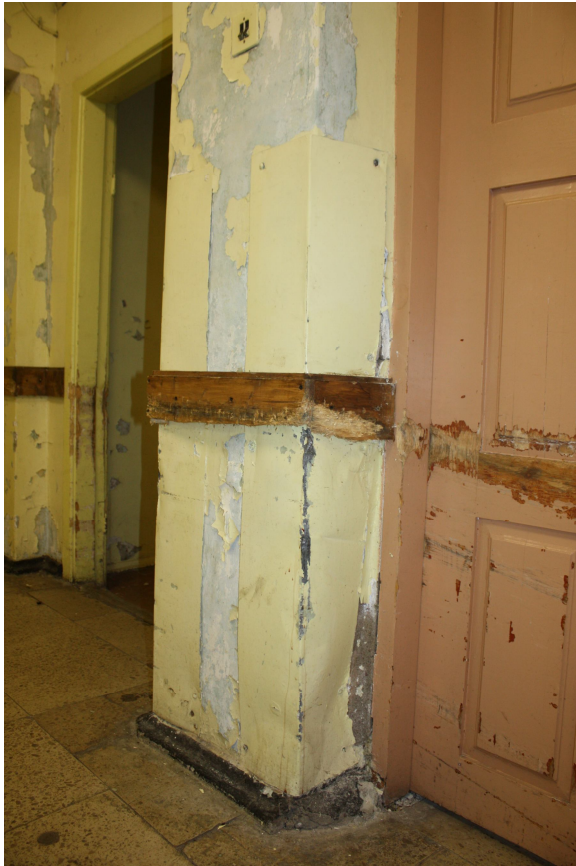
Foto Nr. 65. Krāsojuma kārtas noslāņošanās, koka elementu un durvju vērtnu nodilums telpā Nr. 3
