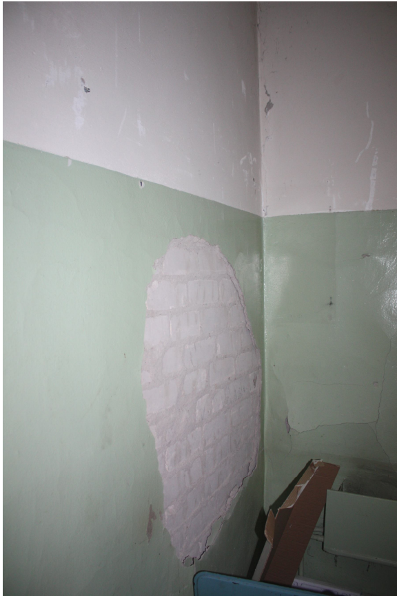
Foto Nr. 57. Apmetuma kārtas noslāņošanās telpā Nr. 18
