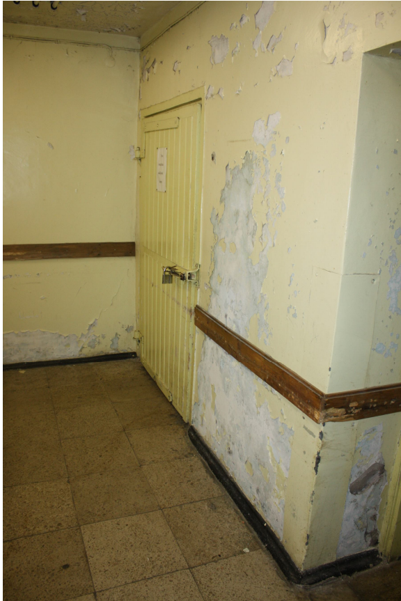
Foto Nr. 64. Krāsojuma kārtas noslāņošanās un koka elementu nodilums telpā Nr. 3
