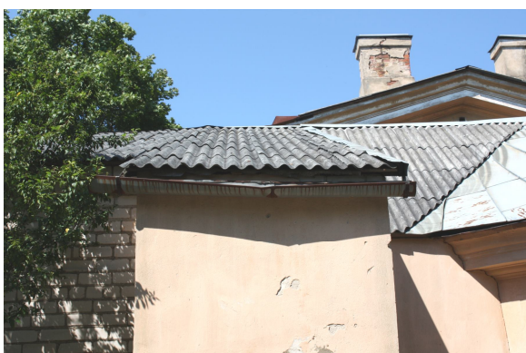
Foto Nr. 33. Ēkas lietusūdens novadsistēma nedarbojas; tekņu posmi ir deformējušies vai nav saglabājušies
