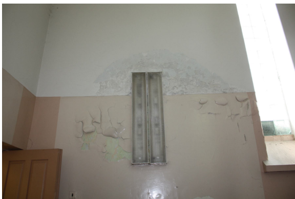
Foto Nr. 66. Krāsojuma kārtas noslāņošanās telpā Nr. 1
